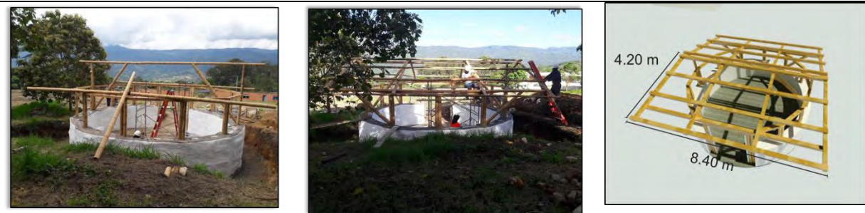
Figura 25 Montaje del tejado Fuente: Autores
