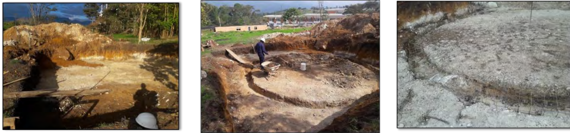
Figura 22 Nivelado del terreno. Fuente: Autores.
